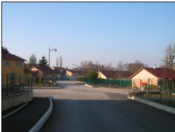
Une chaussée large pour un trottoir étroit
