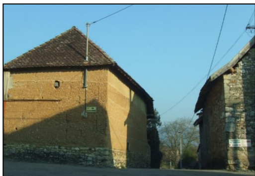
Une ancienne grange réalisée en pisé, Gouvoux, 2011
