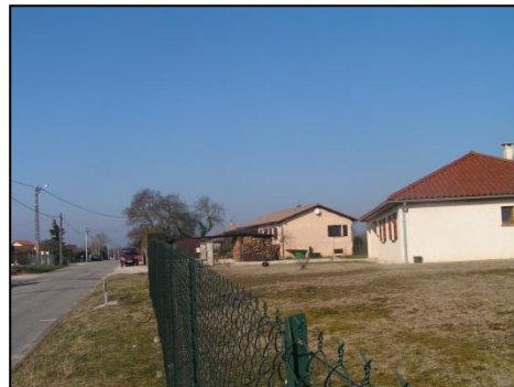
Construction en retrait de la voirie, Roux
