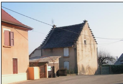
Toit à mantelures, quartier de l'Eglise, 2011
