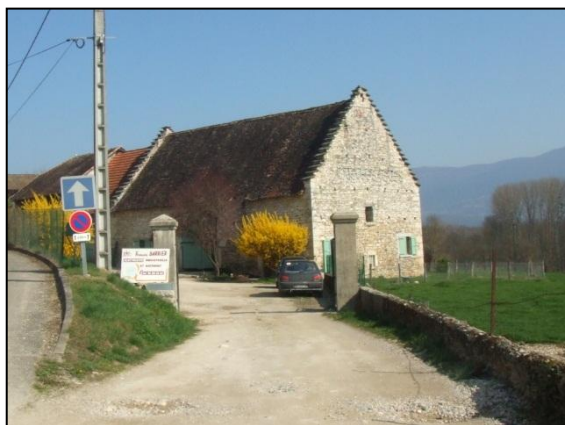
Toiture en mantelure
