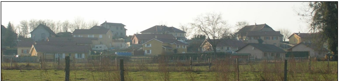
Vue depuis le nord
